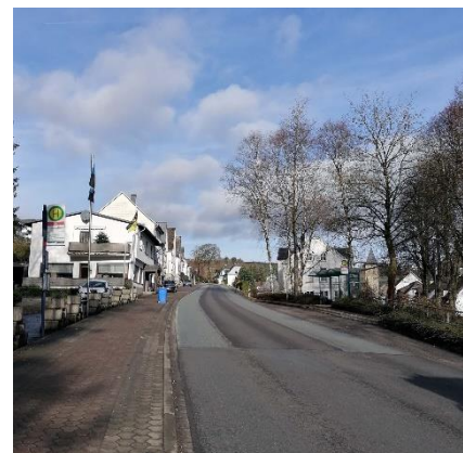
Abb. 5.1: Fahrbahnbelag OD Antfeld [Stadt Olsberg]
