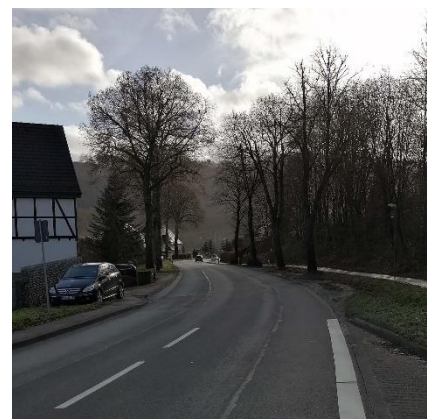
Abb. 5.2: Fahrbahnbelag Antfeld Siedlung [Foto E. Trippe]
