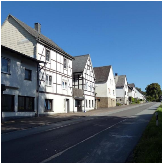
Abb. 9.4: Ortsdurchfahrt Antfeld, B 7 Bundesstraße
