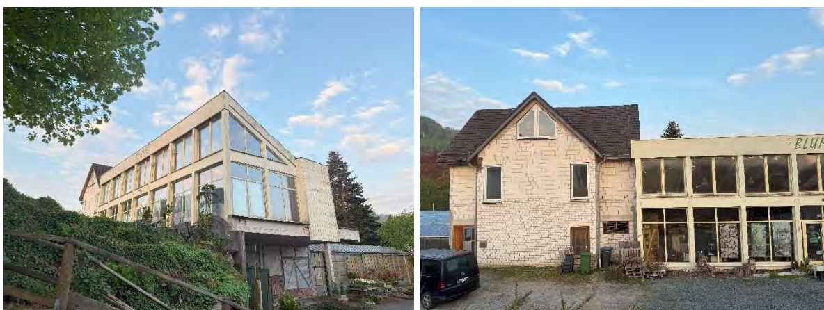
Abb. 11: Blick auf den Gebäudekomplex der Gärtnerei mit Verkaufsräumen im Untergeschoss sowie einem Wohnhaus mit angrenzendem Ladenlokal für floristische Dekorationen auf der darüber liegenden Ebene (Blick aus Nordost (li) und Ost (re))
