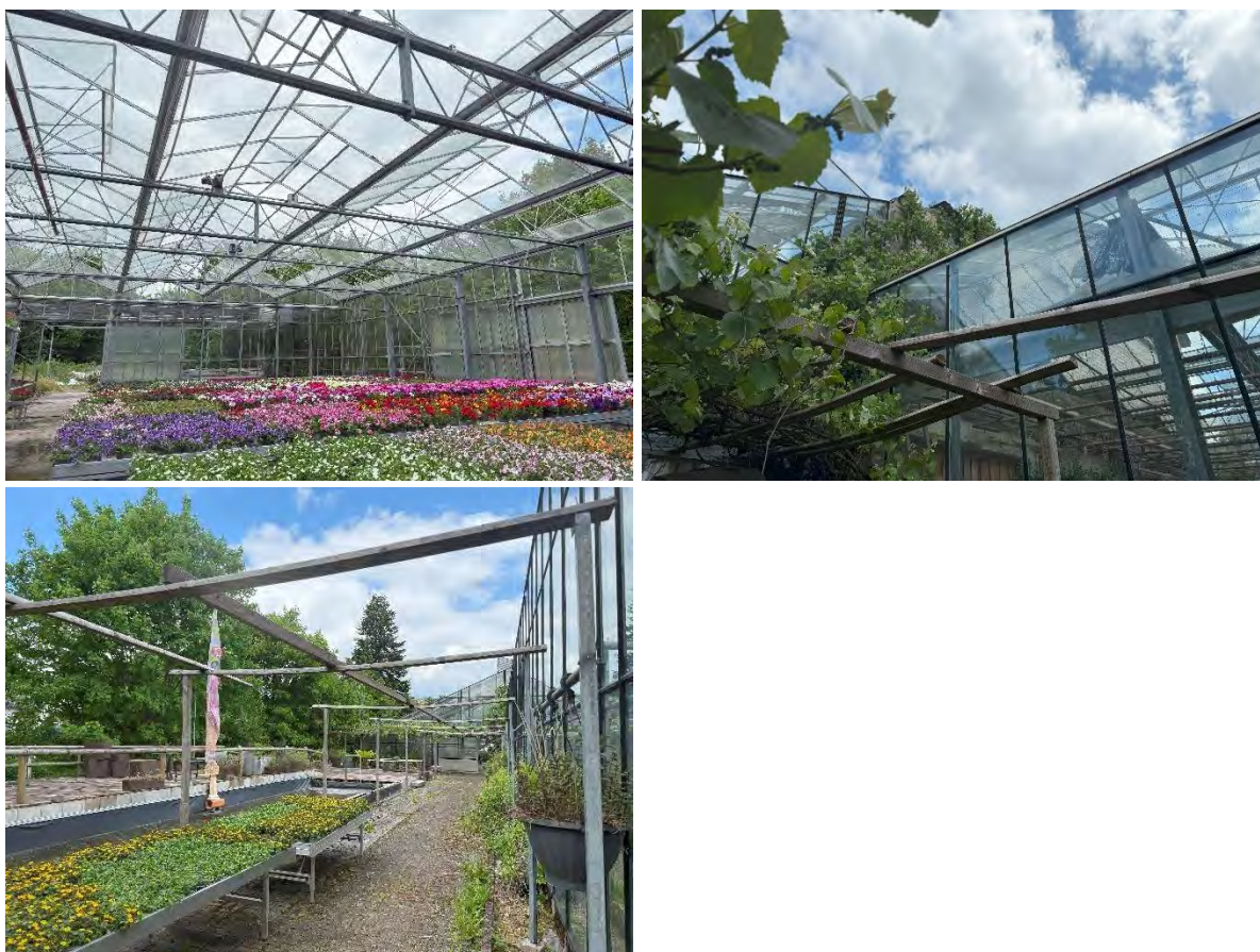
Abb. 15: Im Süden liegende Gewächshäuser und Betriebsflächen der Gärtnerei entlang der im Westen verlaufenden Ruhr
