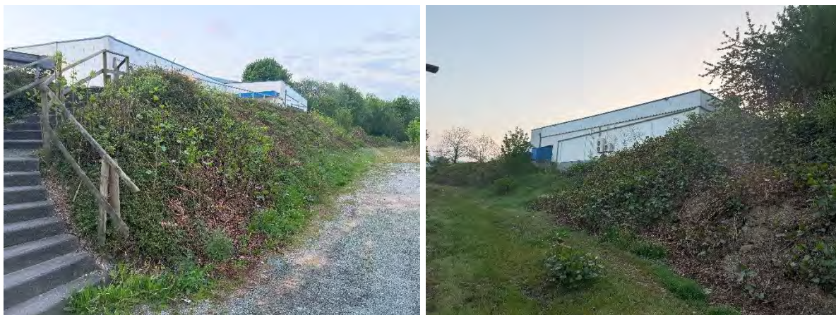
Abb. 9: Von Nord nach Süd verlaufende (mit Staudenknöterich bestandene) Böschung inmitten des Plangebietes
