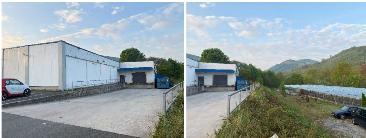
Abb. 7: Aktueller Anlieferungsbereich des Einzelhandels mit angrenzendem Böschungsbereich Richtung Westen und darunter liegenden Gewächshäusern der Gärtnerei
