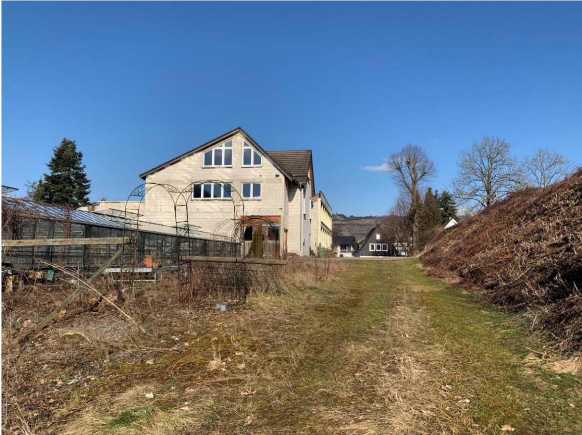
Abbildung 6: Blick von Südwesten auf die ehemalige Gärtnerei links und die Anböschung zum bestehenden Markt rechts
