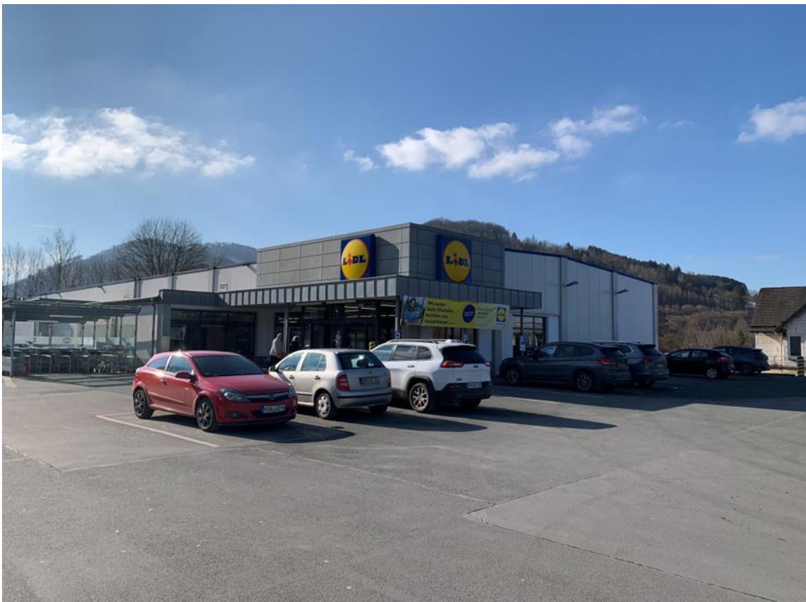
Abbildung 3: Blick von Nordosten auf das bestehende Gebäude
