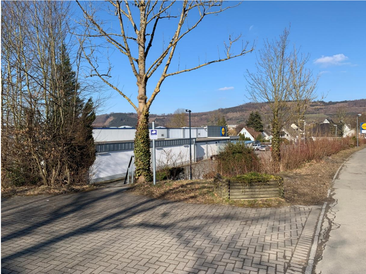
Abbildung 2: Blick von Süden (Carlsaustraße) auf das bestehende Gebäude
