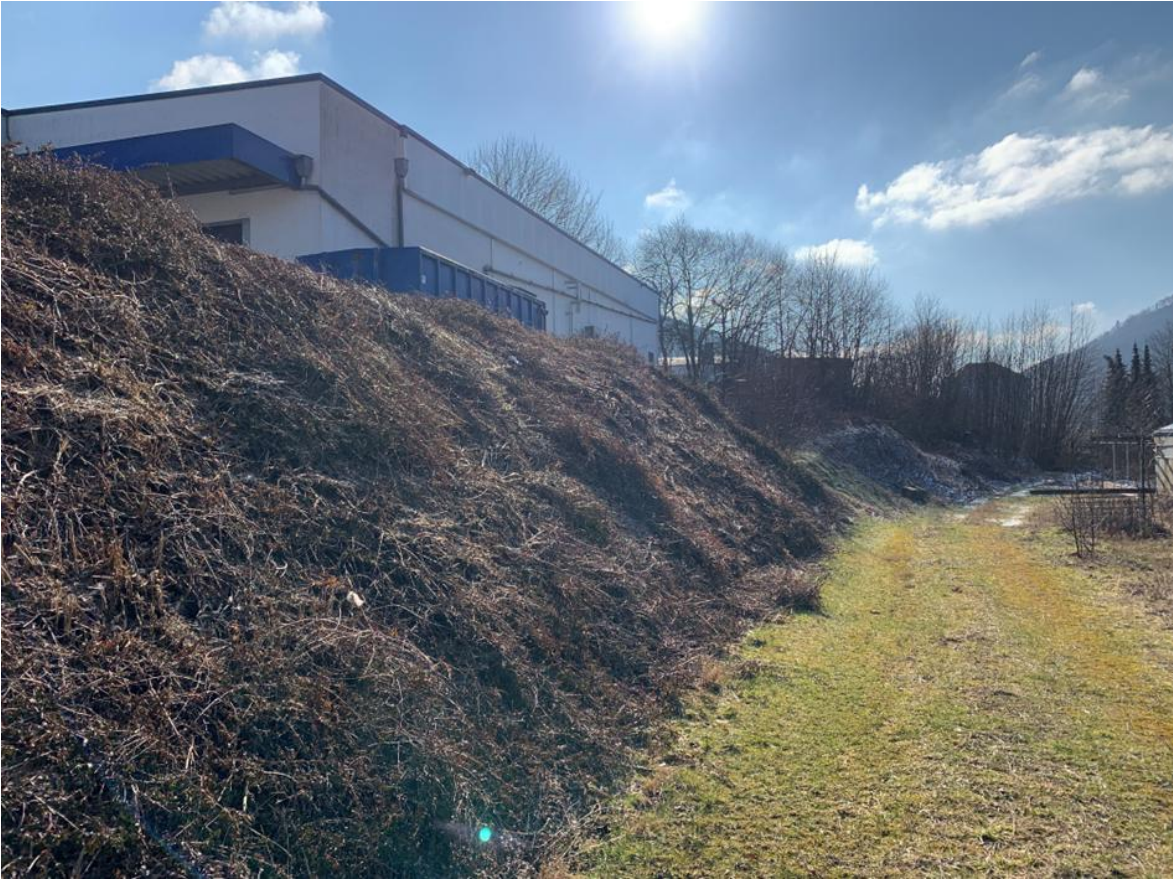
Abbildung 4: Blick von Nordwesten auf die Rückseite des bestehenden Marktgebäudes
